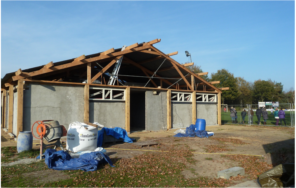
D'n Bauw op een archiefphoto (nov-11) (met de zichtbare constructieonderdelen)
